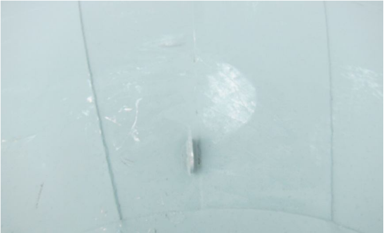
33. Lug on roof.
